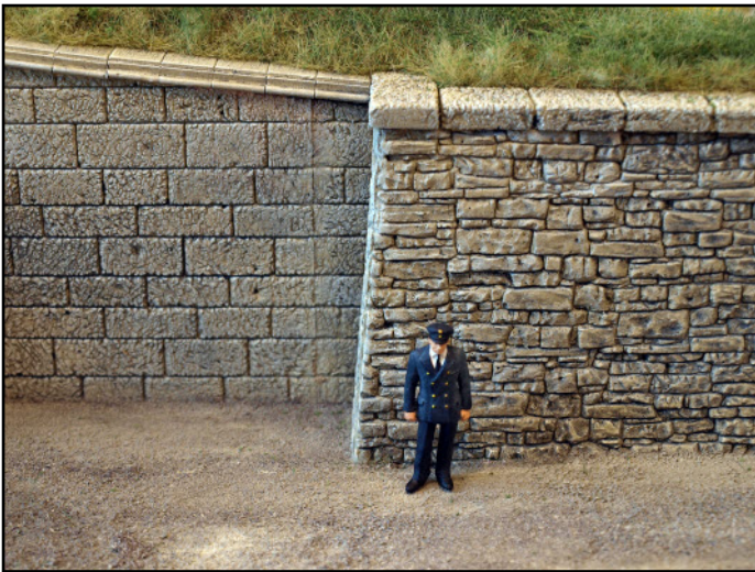
Die Außenecke im Bruchsteinmauerwerk. Innenecke mit Werkstein
